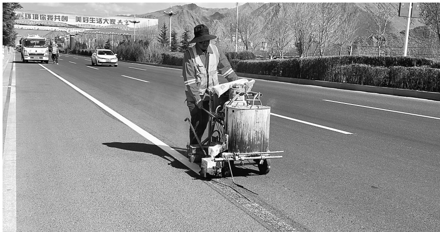
施工人员正在施划交通标线。 记者 姜梦琳 摄
