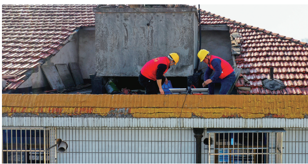
3月2日,余姚市古建小区里,志愿者安装光伏发电板。新华社
