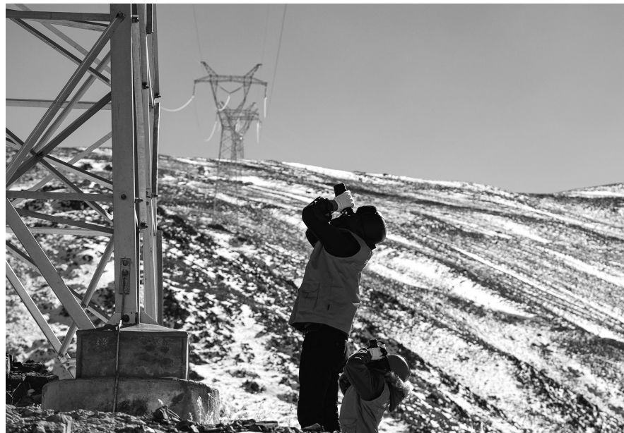
国网阿里供电公司输电中心运检班工作人员在“巴狮1、2线”220千伏霍巴线开展线路特巡。图由国网西藏电力有限公司提供
