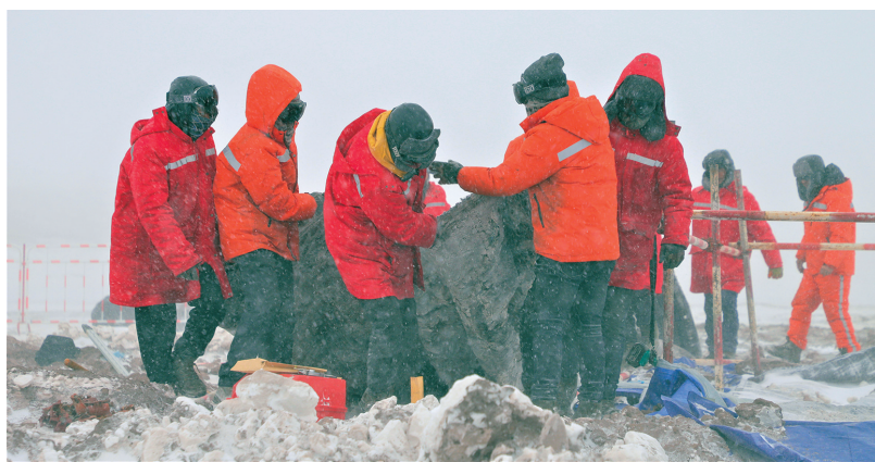
电力建设者在海拔5000多米的阿里联网施工现场。图由国网西藏电力有限公司提供
