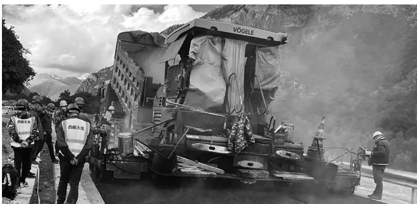
SD项目施工现场。图由自治区交通运输厅提供
