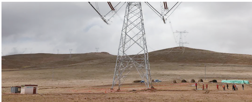
工作人员正在布置工作现场。图由 国网西藏电力有限公司 提供
