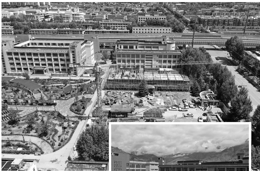
江苏中学施工现场。 记者 阿旺尼玛 摄
