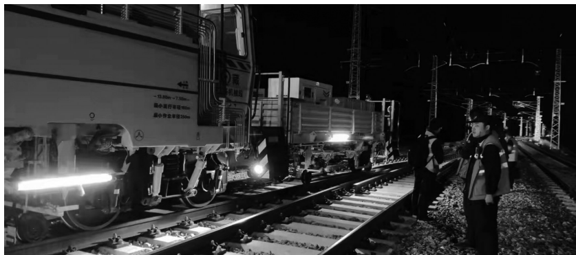
西宁工务机械段维修三车间正在进行捣固作业。
