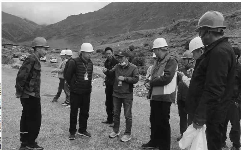
自治区水利厅副厅长热旦检查水库项目建设现场。
