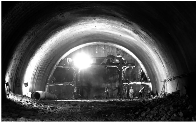
隧道施工。图由自治区交通运输厅提供
