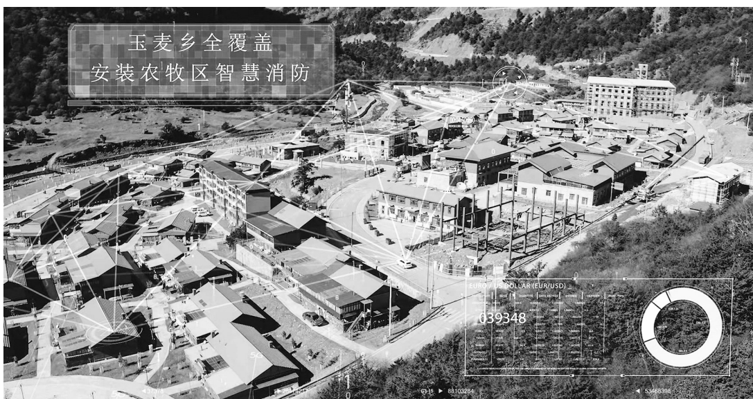
玉麦乡全覆盖安装智慧消防。 图由山南市消防救援支队提供
