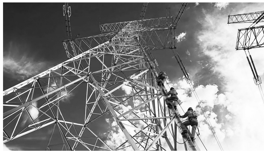
工作人员正在进行高空作业。图由国网西藏电力有限公司提供
