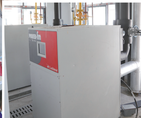
▲锅炉房内机械设备。 ◀教室内学生正在上课。
