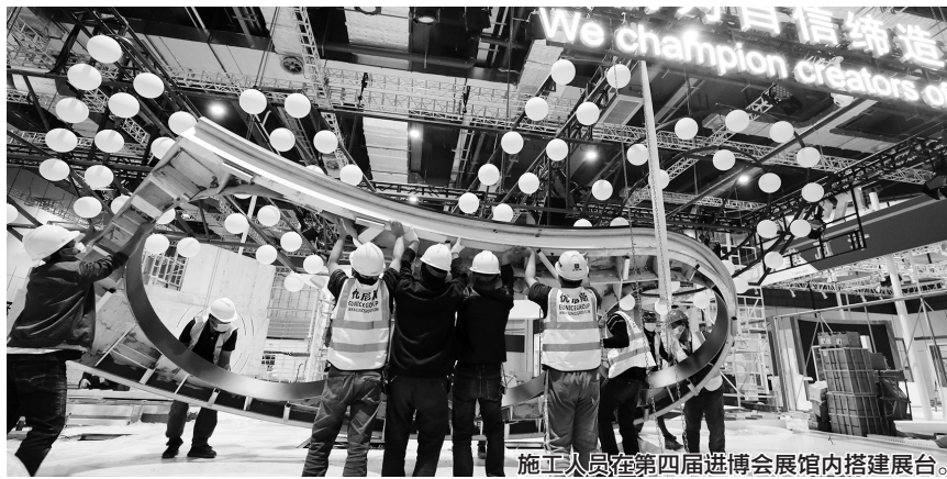
施工人员在第四届进博会展馆内搭建展台。
