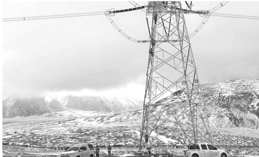
西藏电力检修公司员工在±400千伏柴拉直流1395号塔上开展年检工作。图由国网西藏检修公司提供
