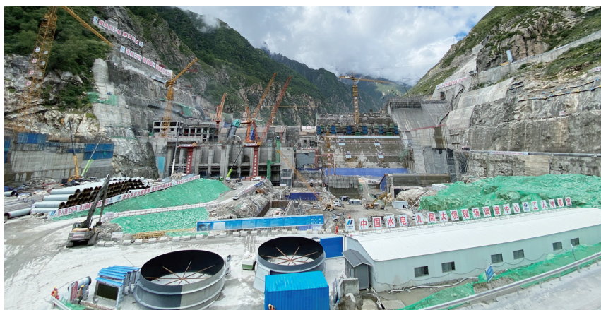
DG水电站施工现场。图由华电西藏DG公司提供
