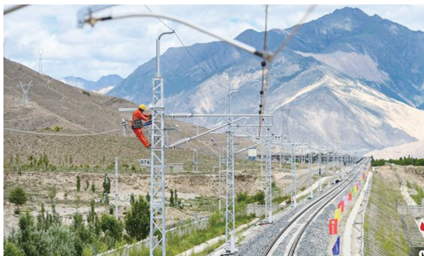
拉林铁路施工现场。中新网
