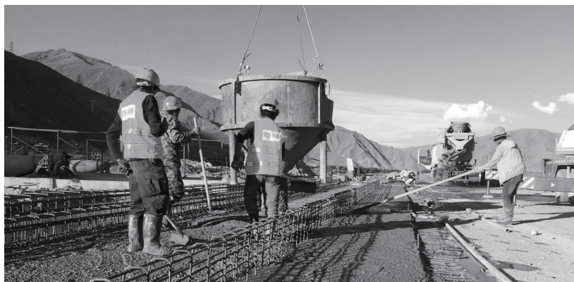
桥梁砼浇筑施工。图由刘洋提供
