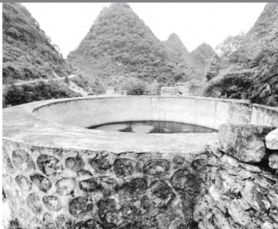
▲中信银行在广西田林县西华村援建的水柜项目。
