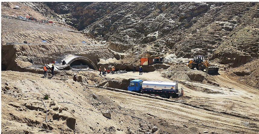
忠材山(中南组团)隧道项目施工现场。
