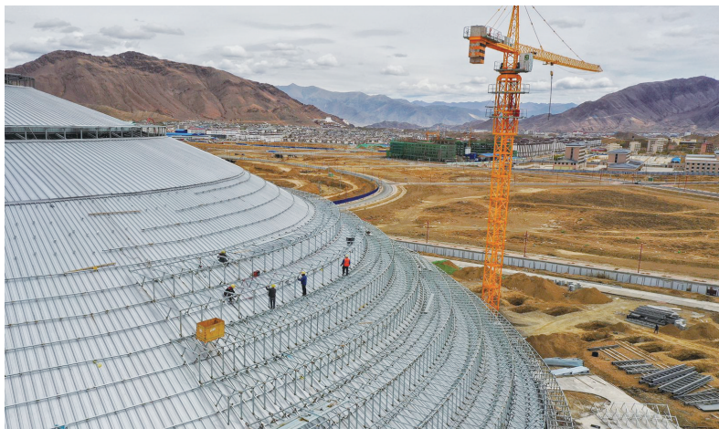
演艺中心施工现场。图由李一男提供
