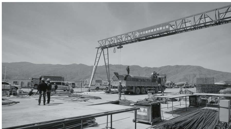
吉纳特大桥施工现场。
