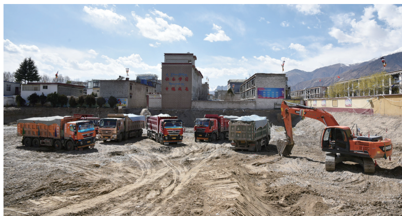
城关区雪小学地下智慧停车场施工现场。
