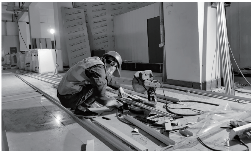
甘露藏药产业集团有限公司第一车间正在施工。
