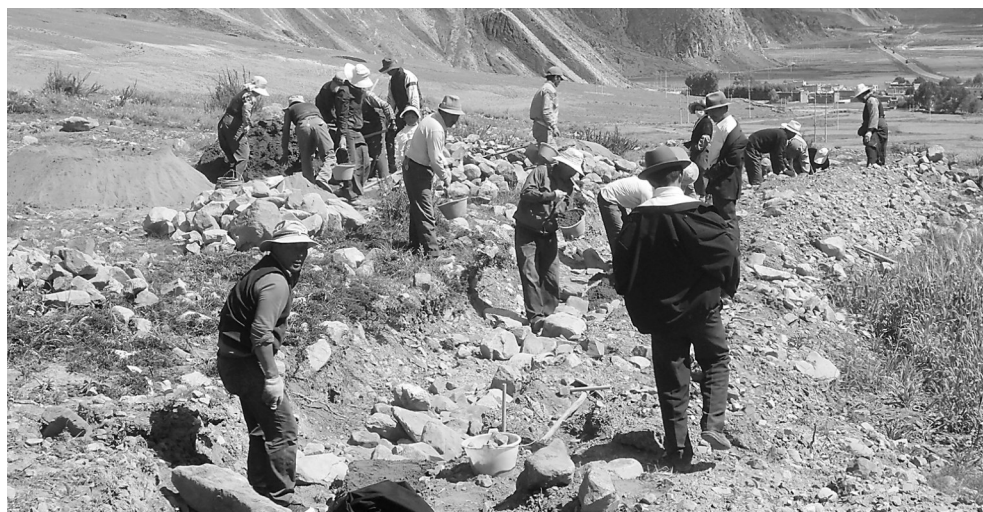
从2011年到2012年,堆龙德庆县马乡共实施整乡推进扶贫项目10个,共争取国家扶贫资金489万元,项目涉及6个村委会、643户贫困户、2967人。同时,完善了乡完小、卫生所等设施建设,使贫困户适龄儿童入学率达到了99%以上,实现了通路、通电、通电话、通邮、通广播、通电视。 图为堆龙德庆县马乡马村扶贫水渠建设项目现场。 本报记者 李洲 摄
