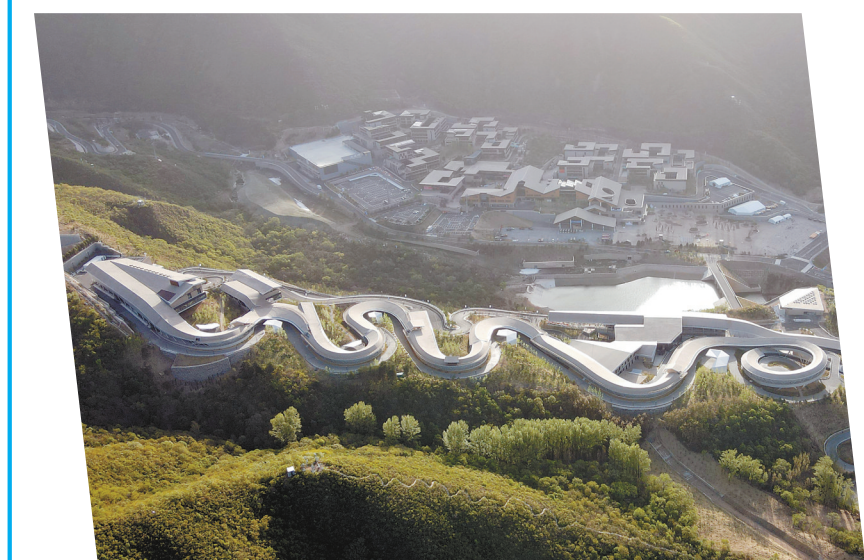
图为2022年4月26日拍摄的国家雪车雪橇中心(下)和冬奥村(上)(无人机照片)。
