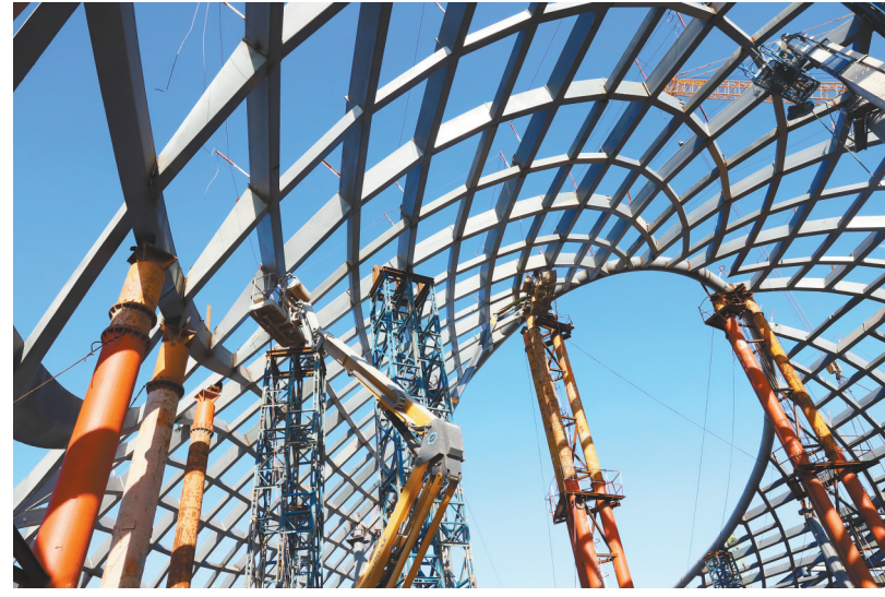
浙江 图为1月1日,浙江省台州路桥机场改扩建工程现场,工人开展航站楼穹顶焊接作业。 新华社发(蒋友青 摄)
