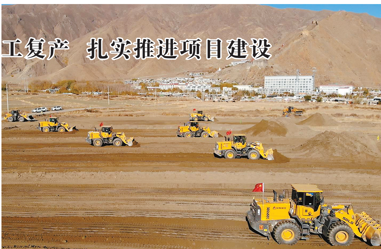
图为琼结县2022年高标准农田建设项目现场,推土机在平整土地。
