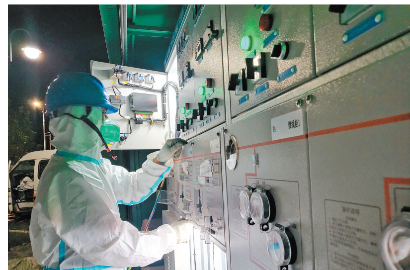
图为国网西藏电科院工作人员对拉萨经开区方舱医院进行供电试验。 本报通讯员 王大飞 本报记者 袁海霞 摄
