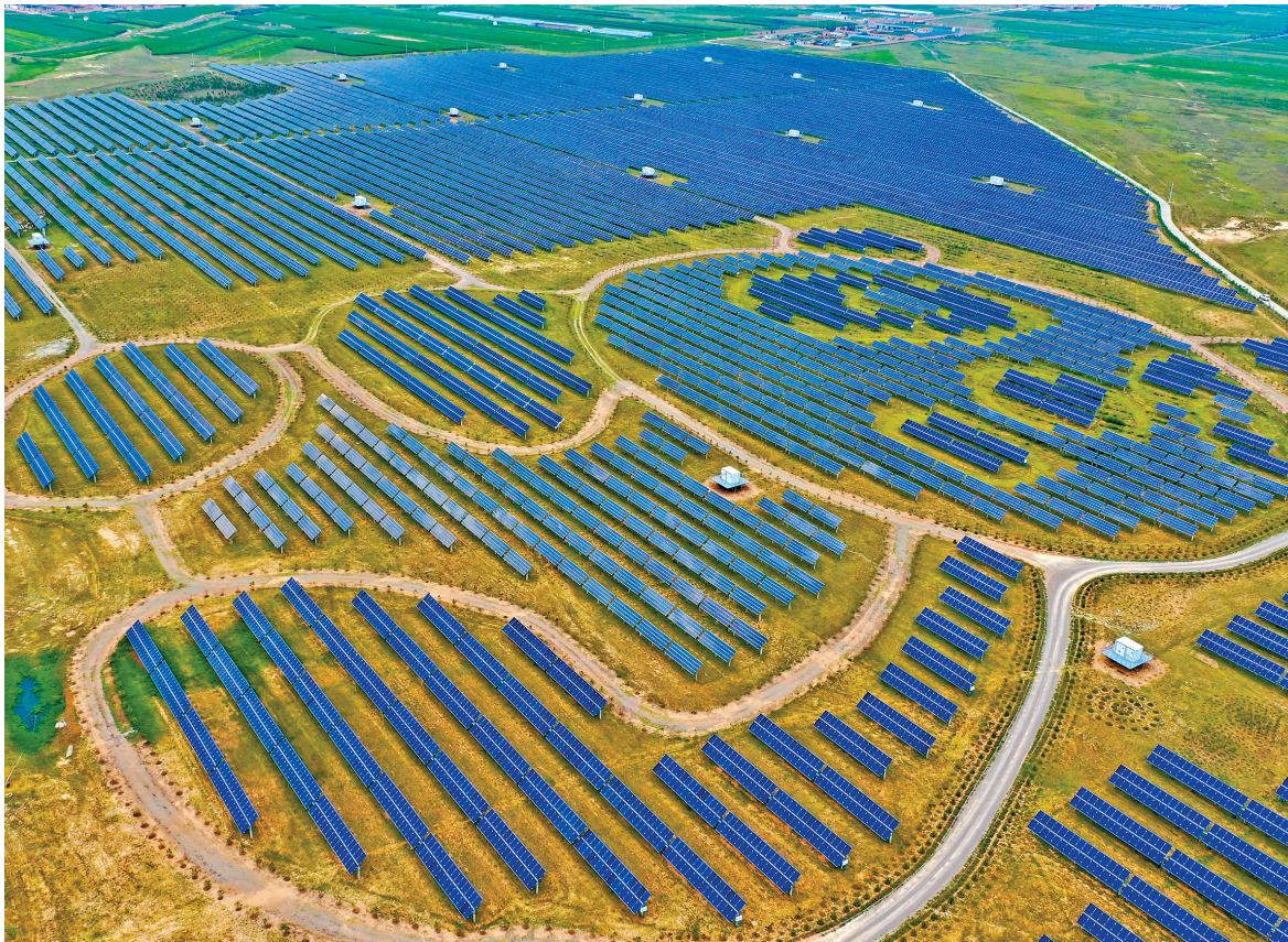
图为位于山西省大同市云州区社庄乡土井村的以熊猫为造型的光伏电站(无人机照片,2021年8月3日摄)。 新华社记者 曹阳 摄
