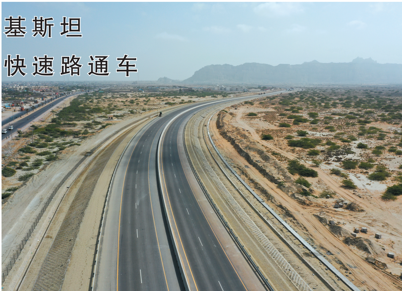
图为6月3日,在巴基斯坦西南部俾路支省瓜达尔航拍的瓜达尔东湾快速路。新华社记者蒋超摄
