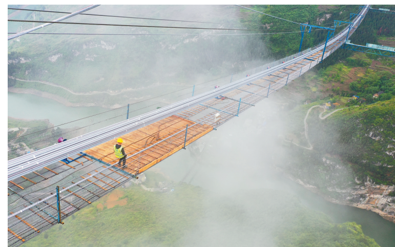
5月1日，工作人员在由中铁广州局承建的贵州金(金沙)仁(仁怀)桐(桐梓)高速桐梓河特大桥建设现场行走(无人机照片)。
