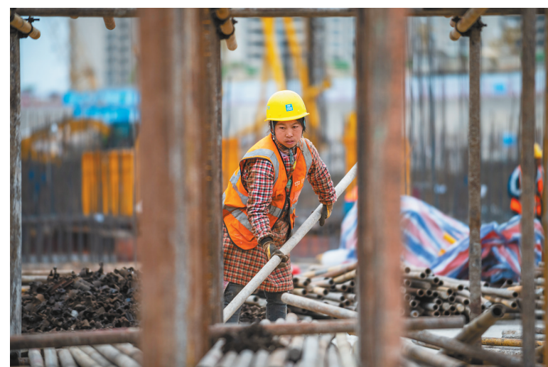
5月1日，在中建七局西南公司昆明斗南花卉小镇花卉产业综合配套服务区(一期)项目建设工地上，工人在搬运钢管。
