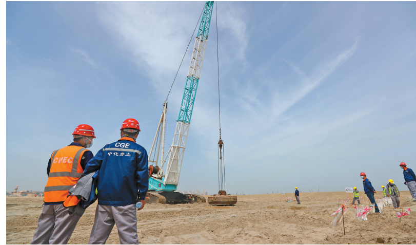
图为3月31日,在埃及亚历山大,工人在阿布基尔集装箱码头项目地基处理分项工程开工仪式现场观看强夯机作业。新华社记者 隋先凯 摄
