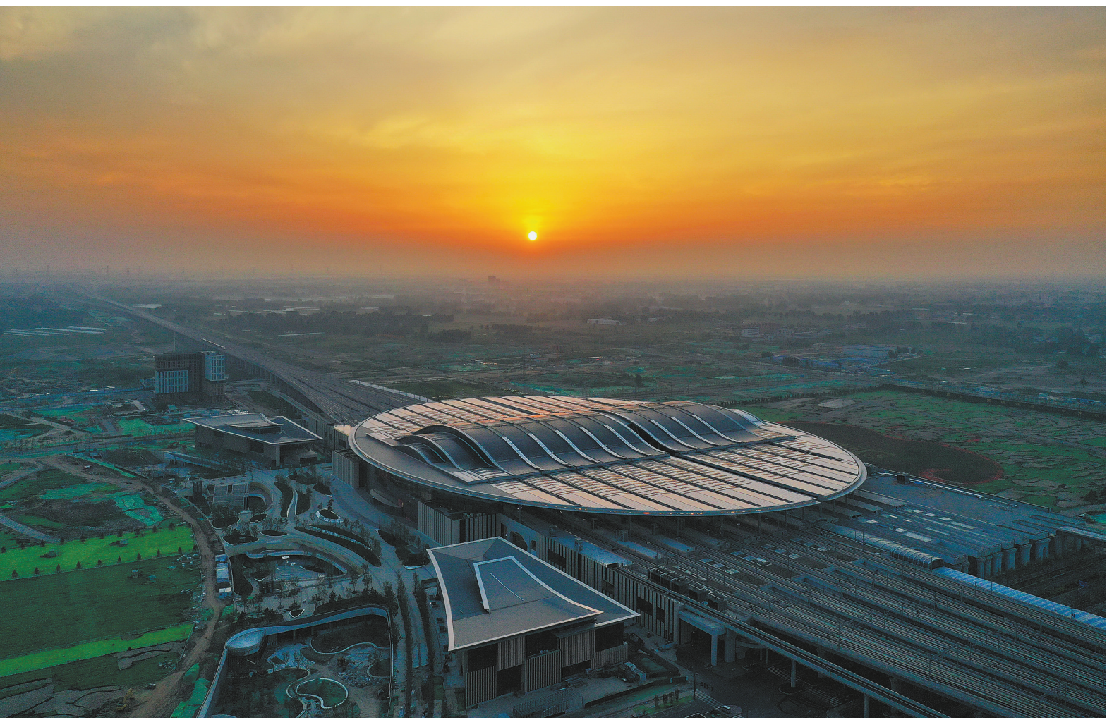
这是2021年7月1日拍摄的京雄城际铁路雄安站(无人机照片)。
