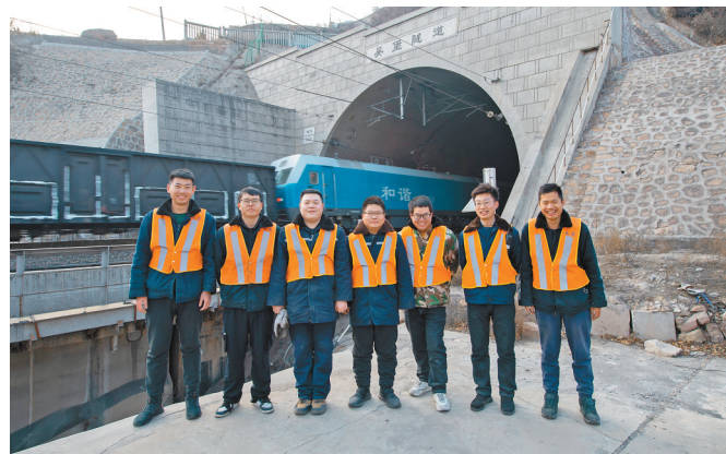
吴堡隧道全长12.3公里,是太中铁路地质构造极为复杂、维护难度最大的一座隧道。漆黑的隧道里,交错的暗管间,这些“90后”桥隧工化身“超级玛丽”,默默守护着春运行车安全。
