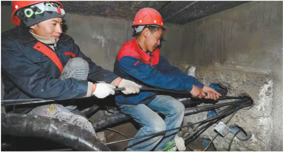
图为中国电信西藏公司职工在修建光缆。(图文均由中国电信西藏公司提供)
