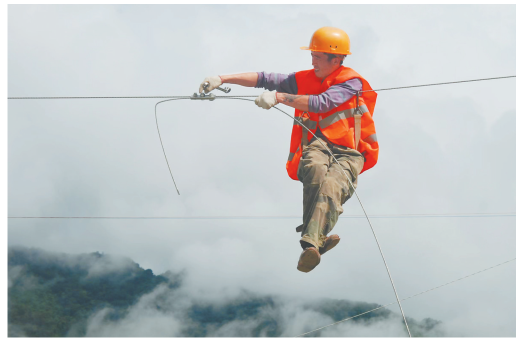
图为中国电信西藏公司职工在高空架设光缆。
