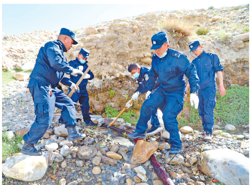
图为普兰县公安局民(辅)警在赤德村口水源地铺设饮用水管道。
