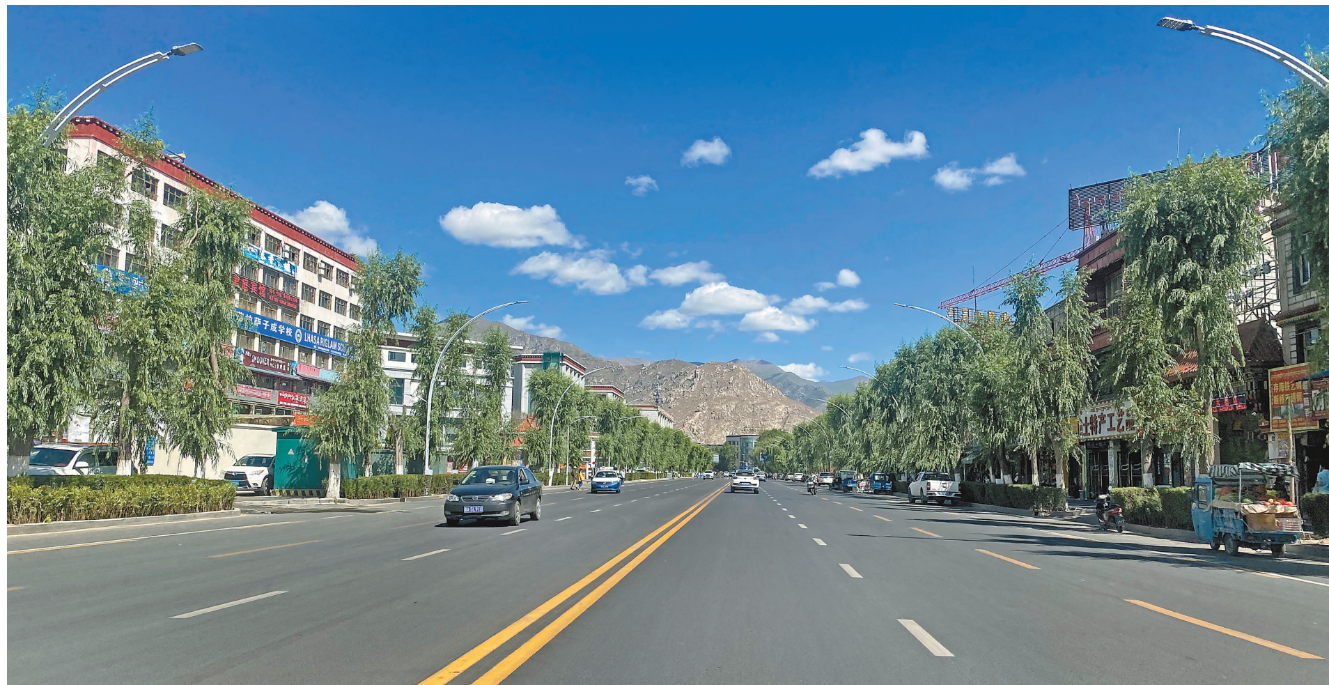
连日来，拉萨市对市区主干道破损路面、护栏、路灯等进行升级改造，不仅极大程度改善了交通环境，也大大提升了城市形象。图为改造升级后的拉萨江苏东路路面。
