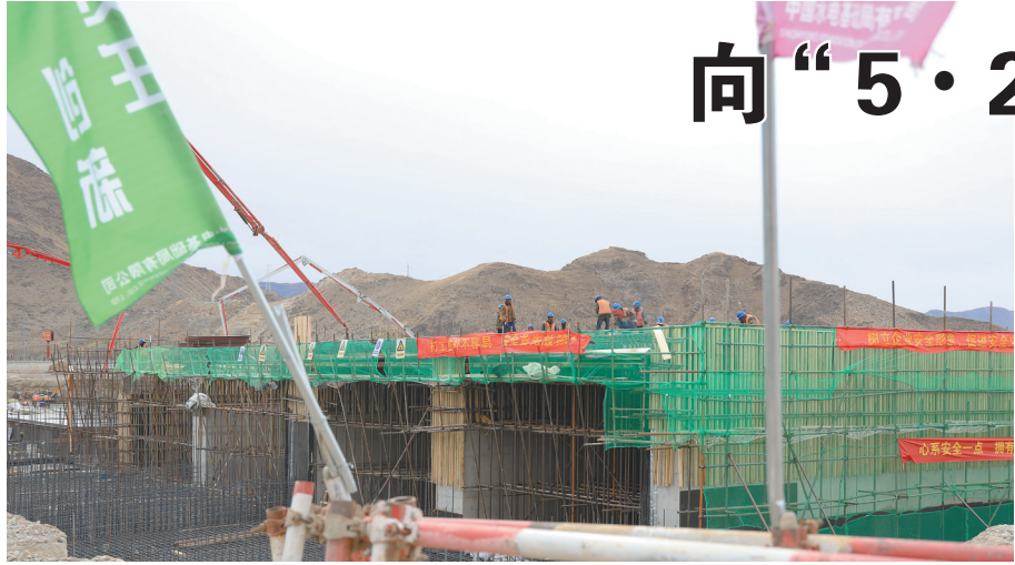
图为拉萨河河势控导工程施工现场。
