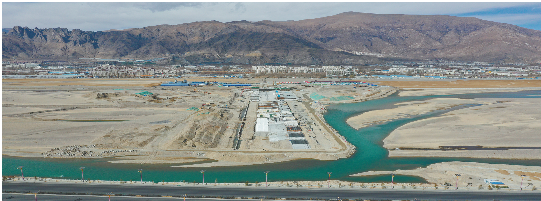
拉萨河河势控导工程(滨河花园段)全景图。
