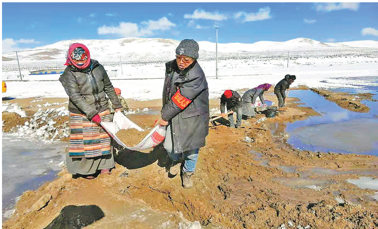
驻村期间，罗布顿珠(左二)同村民一起对严重影响农牧民生产生活的渗水口进行了堵截。
