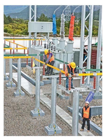
8月10日,随着拉(萨)林(芝)铁路林芝110千伏变电所牵引变压器的安装就 位,拉林铁路全线9座牵引变电所的18台牵引变压器全部安装完成。图为中铁电 气化局集团的技术工人在拉林铁路西藏米林牵引变电所安装主变压器。
