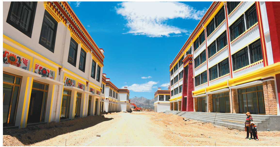
图为即将竣工的多玛乡小城镇建设商业街项目。
