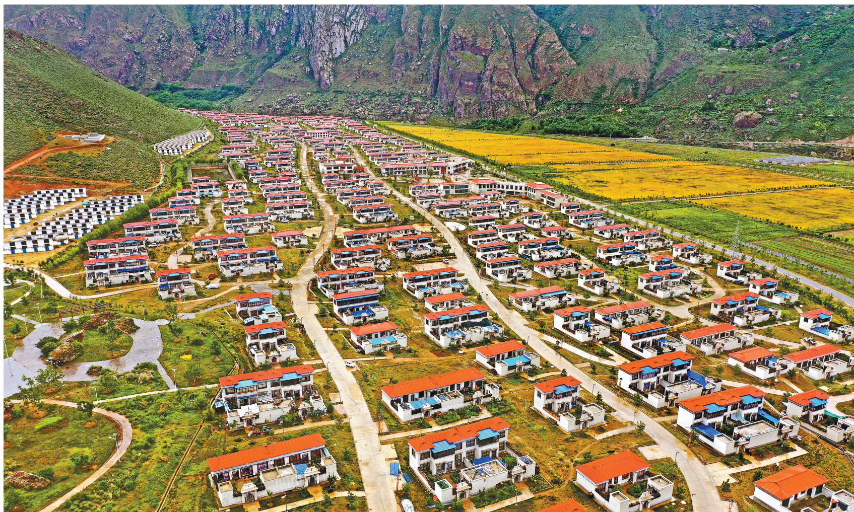
山南市加查县共康村易地扶贫搬迁新村,由加查县、曲松县、隆子县、措美县4县369户1296名贫困户群众于2018年7月搬迁组成,其中建档立卡贫困户248户842人。图为共康村易地扶贫搬迁点全景。
