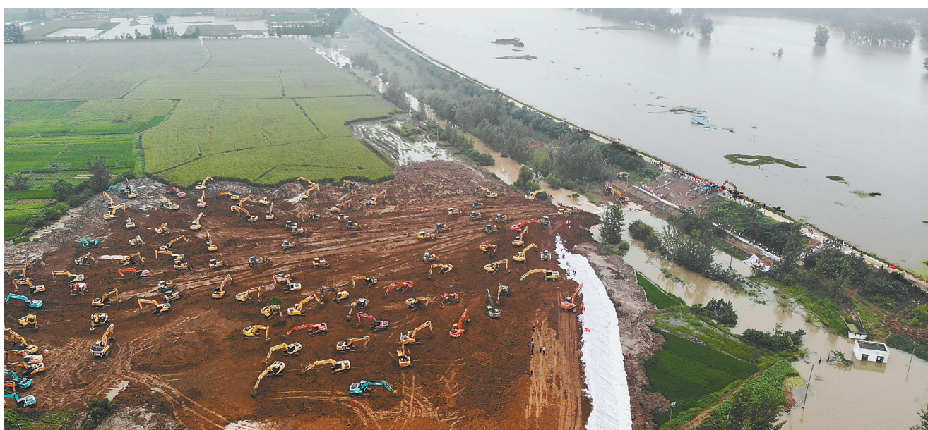
7月28日, 在姜唐湖蓄洪区戴家湖一处涵洞险情处置现场, 人们操作机械设备在抢筑临时圩堤(无人机照片)。
