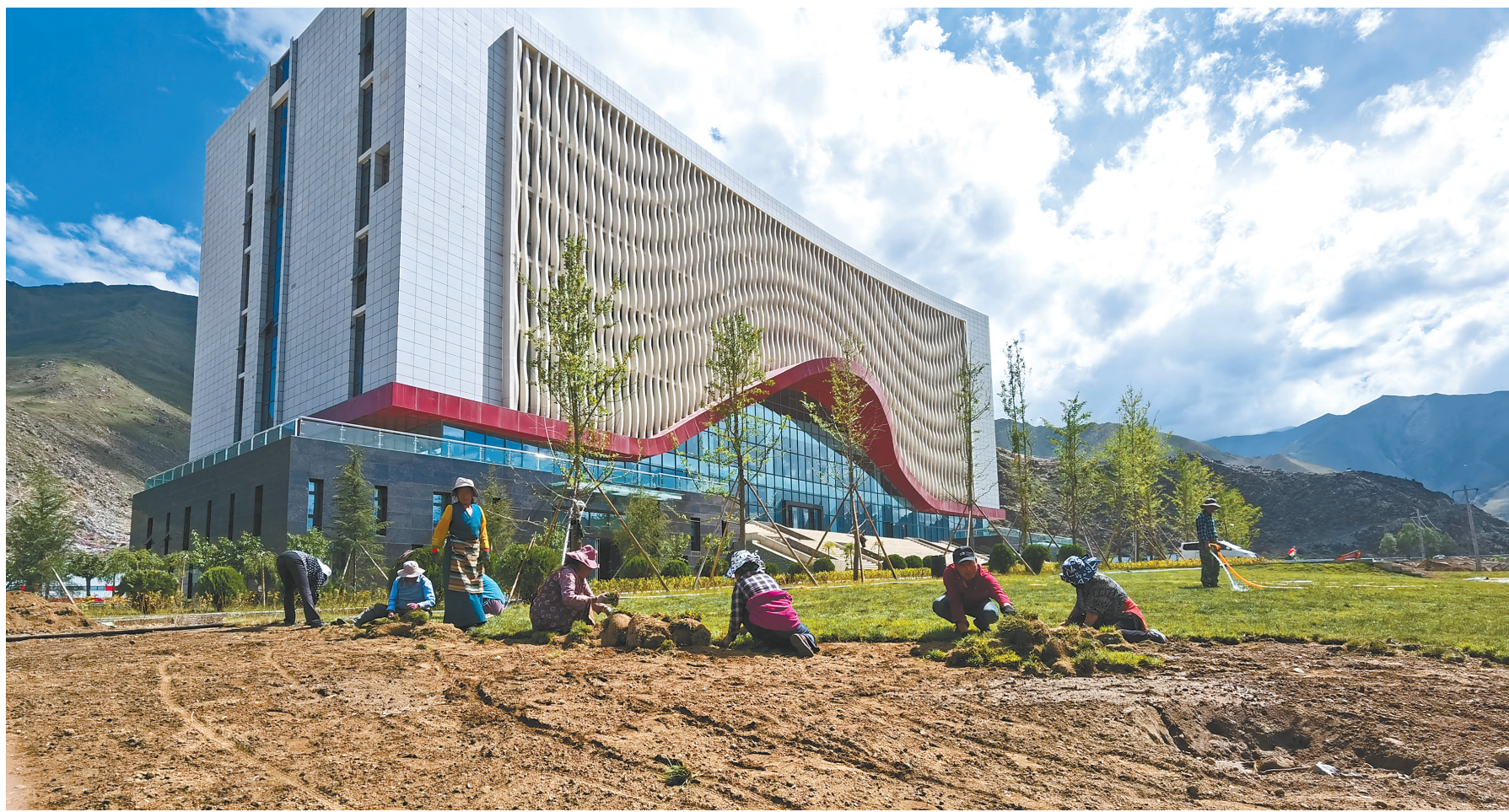
图为综合保税区海关联检大楼前，工人正在进行草皮铺设、园林绿化等工作。
