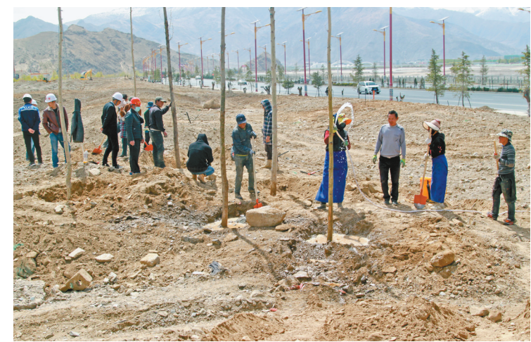
图为柳梧新区滨河路绿化项目建设施工现场。
