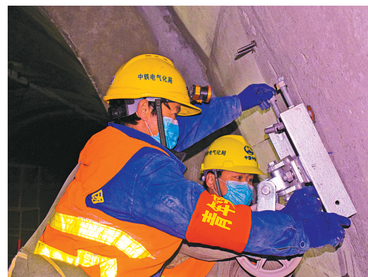
因为拉林铁路四电项目吉隆隧道内，“青年突击队”的电气化工人们正在安装铁轨底座，为后期拉网送电做好准备。
