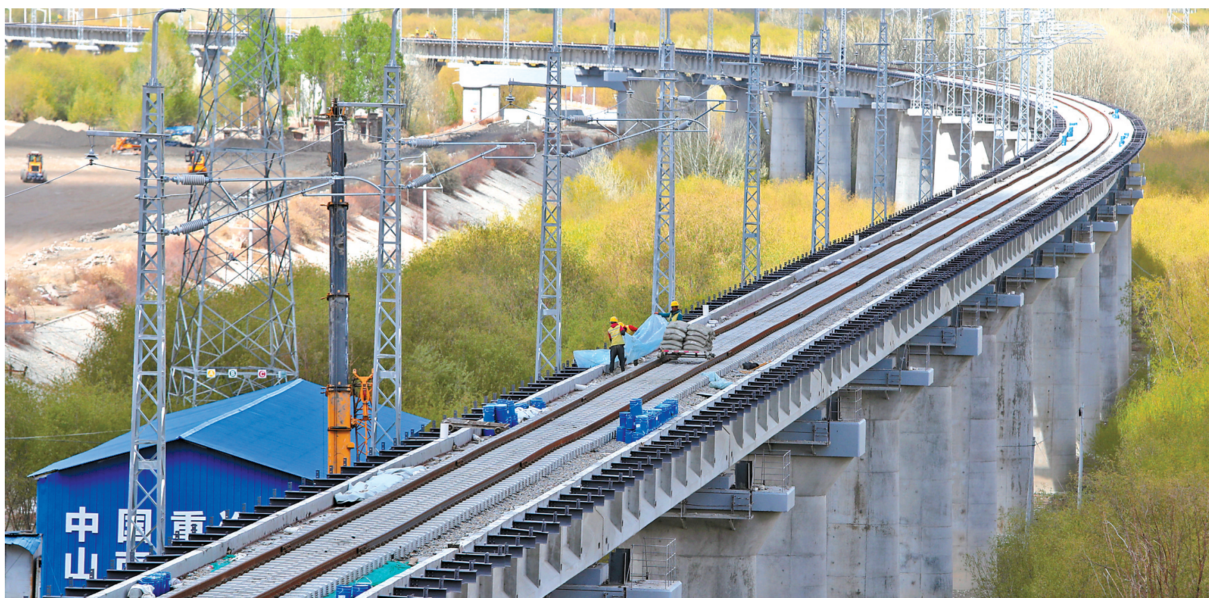
连日来，拉林铁路项目建设者们在做好疫情防控的前提下，加快项目建设进度，确保高质量按时完成建设任务。
