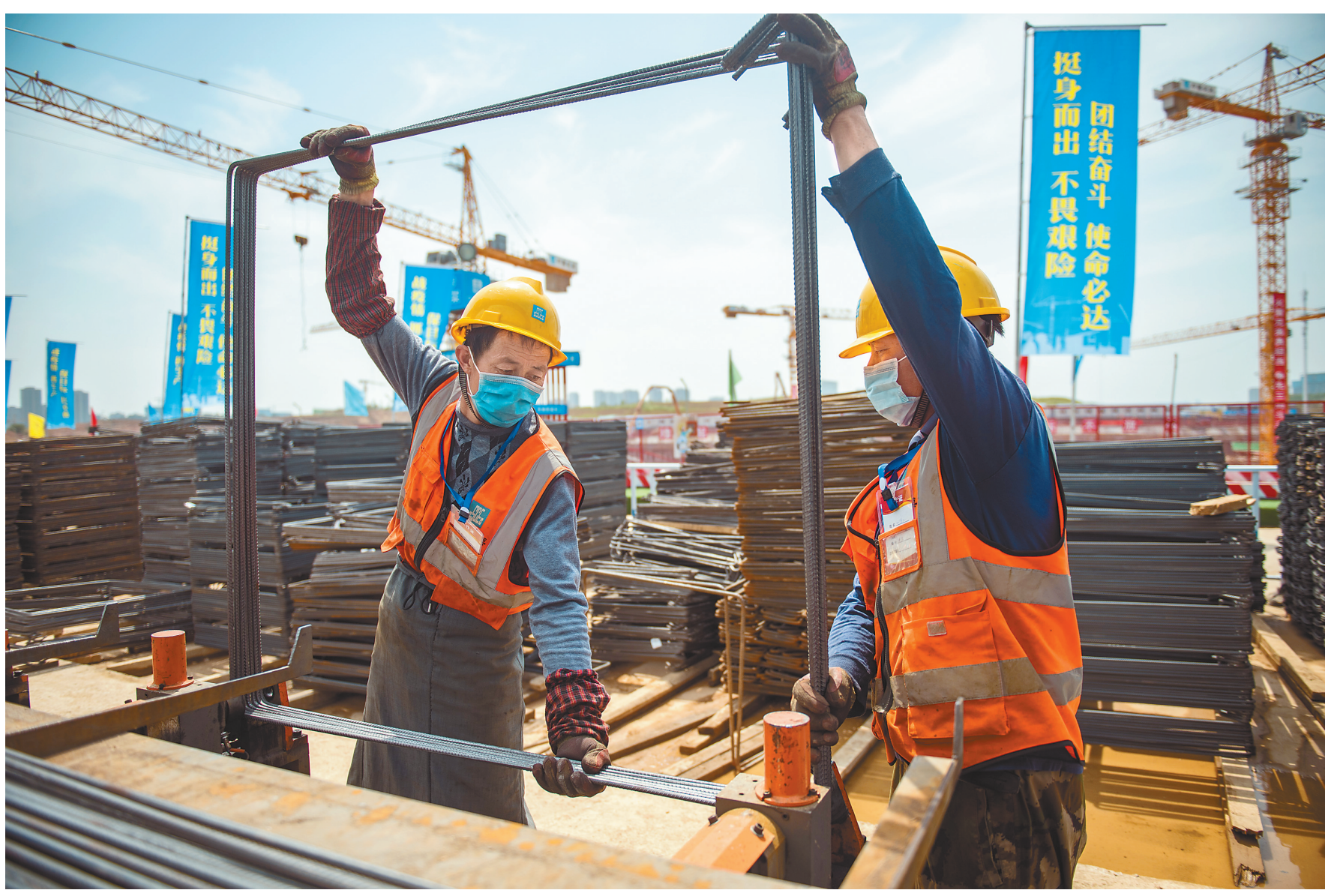
当日,武汉光谷大悦城建设工地上机声隆隆,塔吊转动,来自中建三局的800多名建设者在现场加紧作业,一片热火朝天的施工景象。这些建设者大多都参与过武汉火神山、雷神山医院建设,人们亲切地称他们为“火雷兄弟”。“火雷兄弟”从“两山”医院回来后,经过14天的隔离观察,又投入了复工复产。 这是4月28日,来自中建三局的建设者在武汉光谷大悦城建设工地作业。 新华社记者 肖艺九 摄
