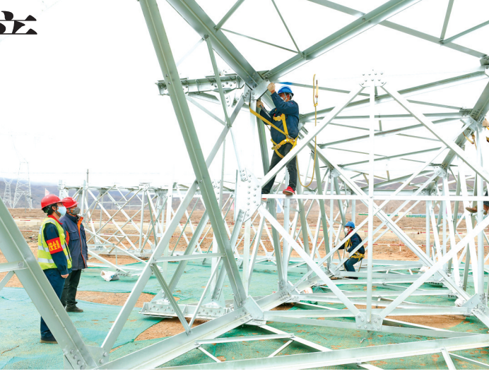
图为阿里与藏中电网联网工程施工现场。 本报通讯员 闫昱翰 本报记者 袁海霞 郑璐 摄
